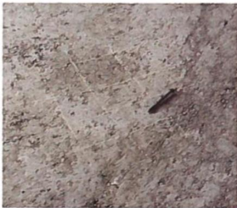
Șapă adecvată — potrivită pentru instalarea parchetului.
