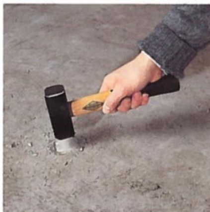
Șapă care cedează la lovire — nepotrivită pentru montarea parchetului.
